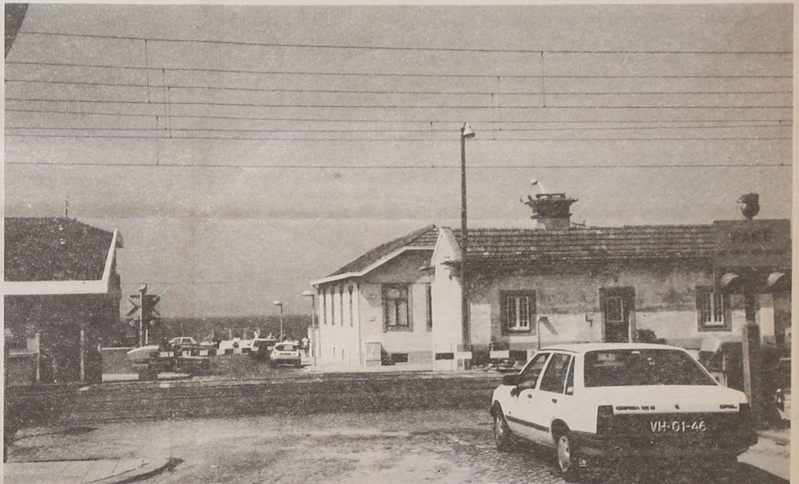
Executivo delibera aceitar proposta da CP sem salvaguardar a segurança dos peões e sem alterar a postura de trânsito.
