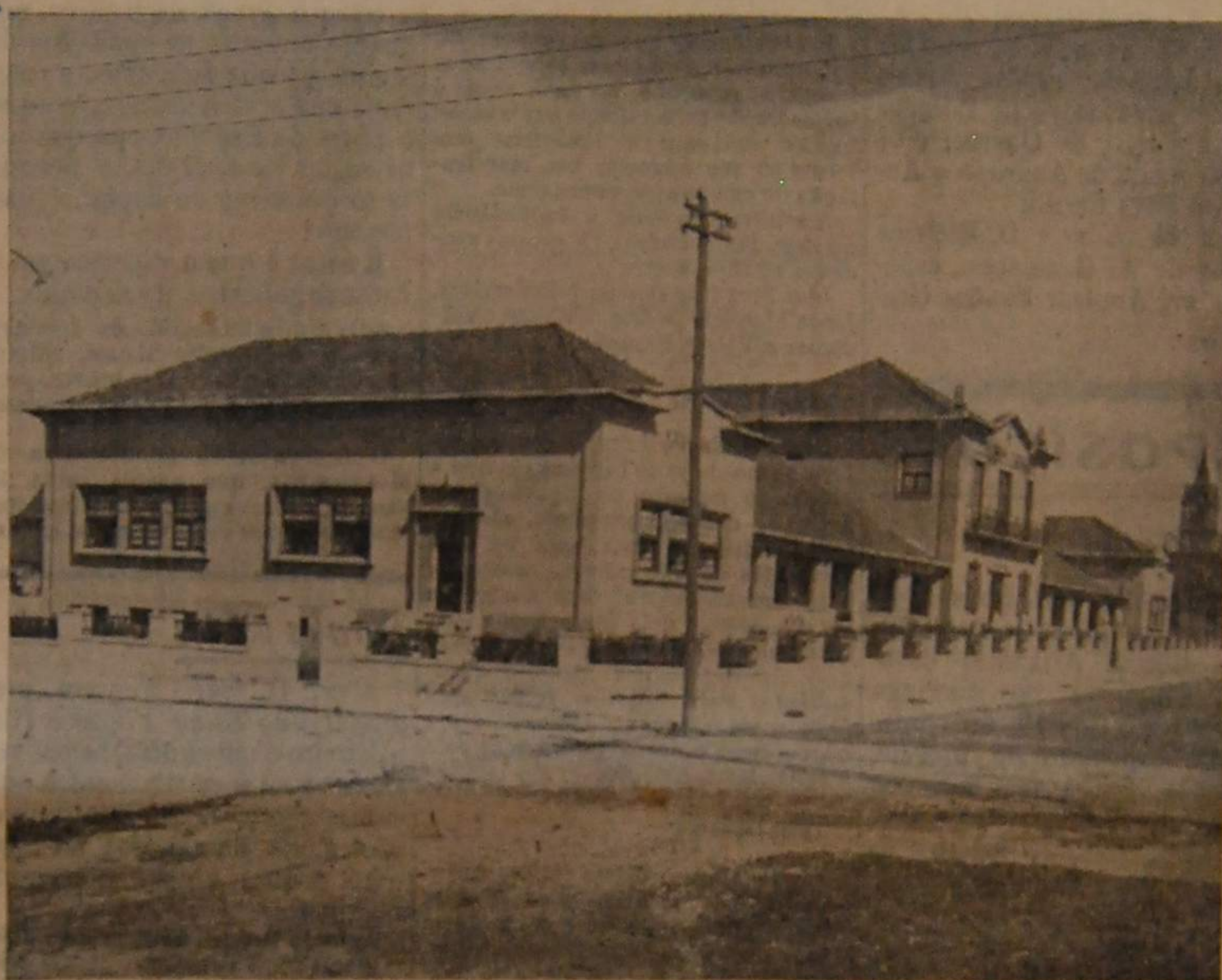
Fachada principal do edificio das Obras Sociais da Fosforeira Portuguesa
