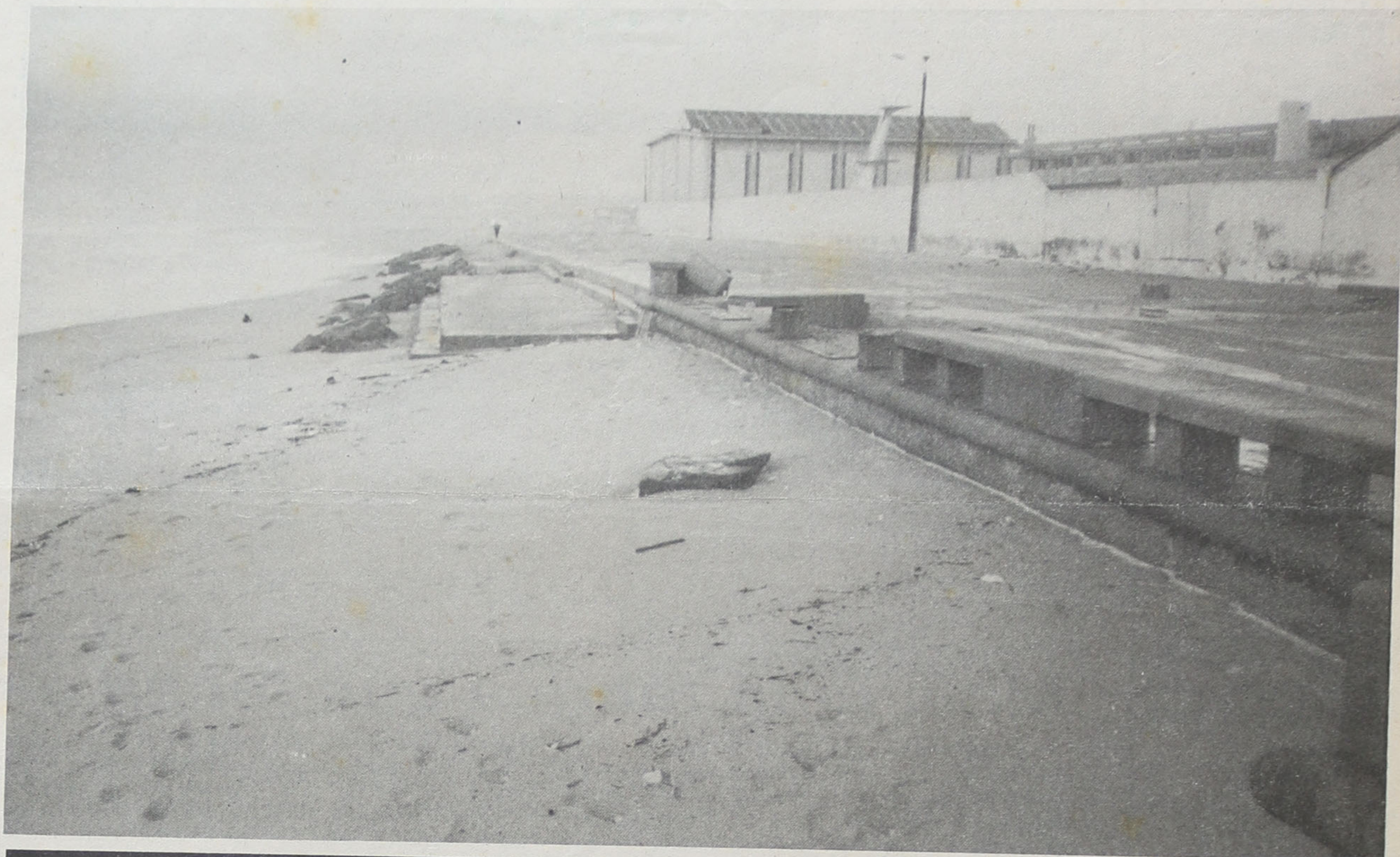
A obra do passeio da beira-mar entra pelo areal, chegando a atingir uma profundidade de trinta metros.
