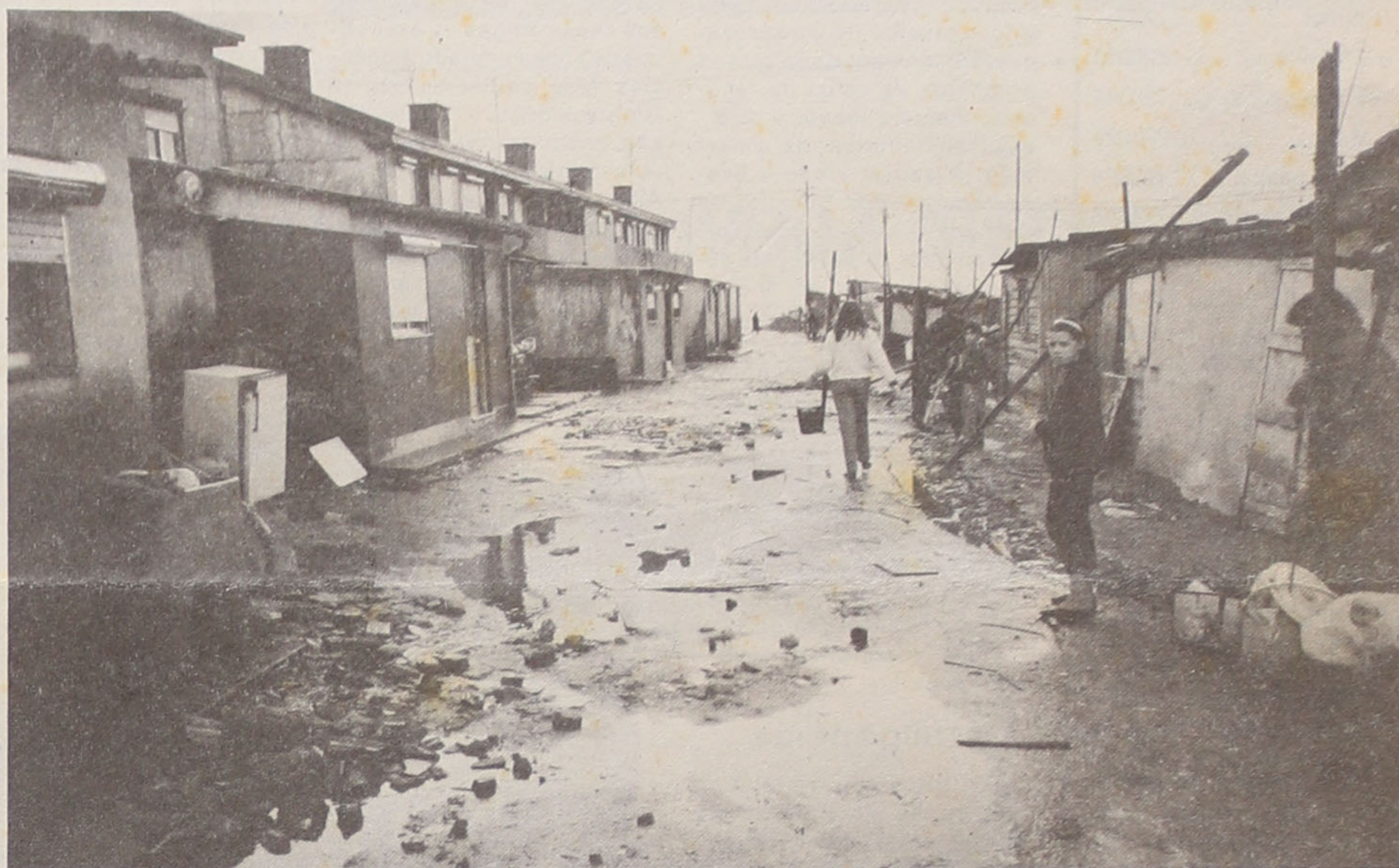
A grande intensidade das chuvas fez com que o nível das águas da Ribeira de Silvalde se elevasse, inundando vários barracos do bairro da Marinha
