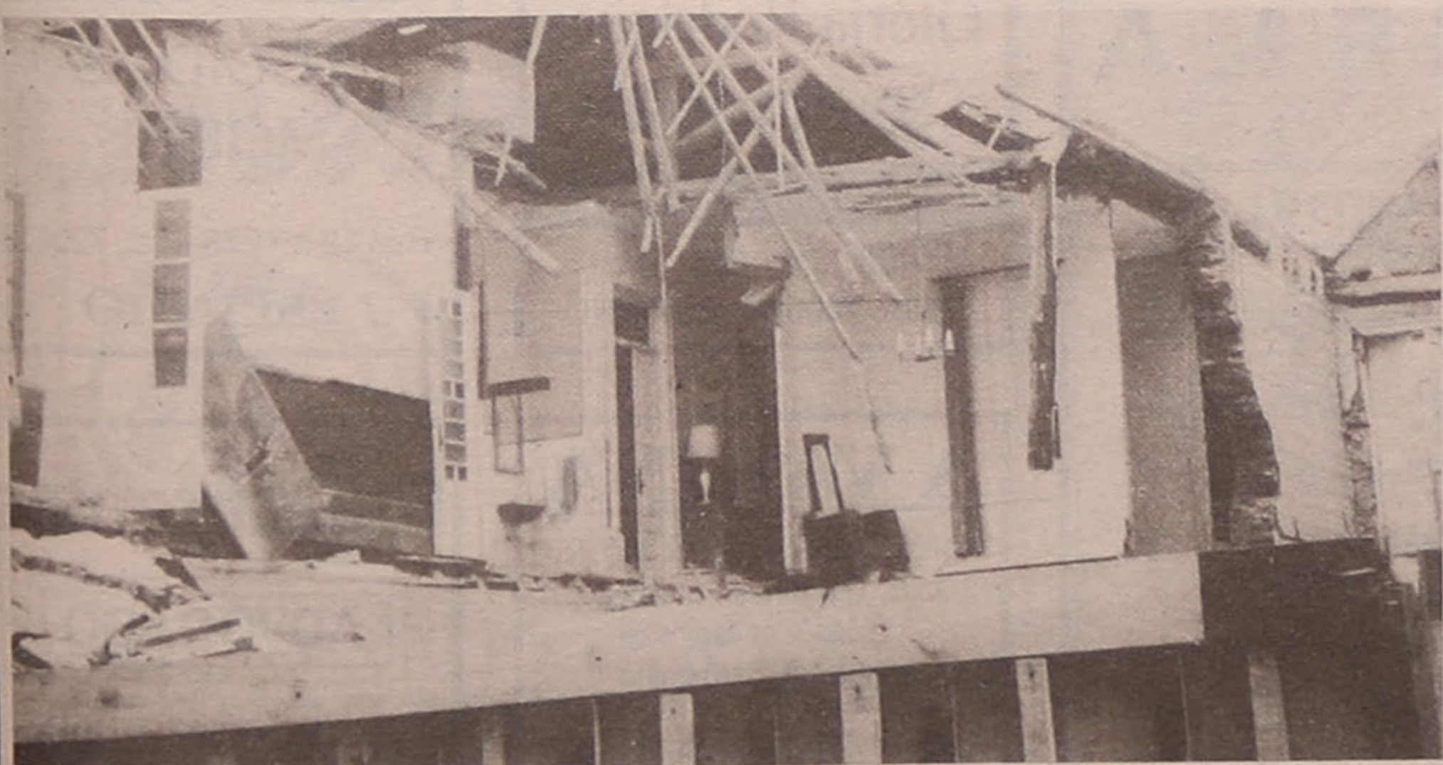
Em plena rua dezanove, obras provocam demolição do prédio ao lado
