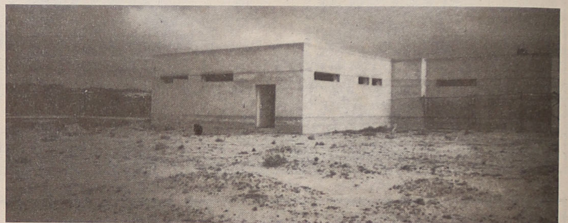
Problemas no nível freático do solo levaram a atrasos sucessivos
