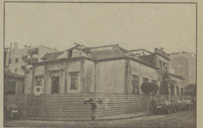
As obras de reconstrução da ex-escola da rua 23 estão paradas, há tempos, porque é necessário estudar o desaterro do seu interior para ser construída uma cave com 6 metros de profundidade.
