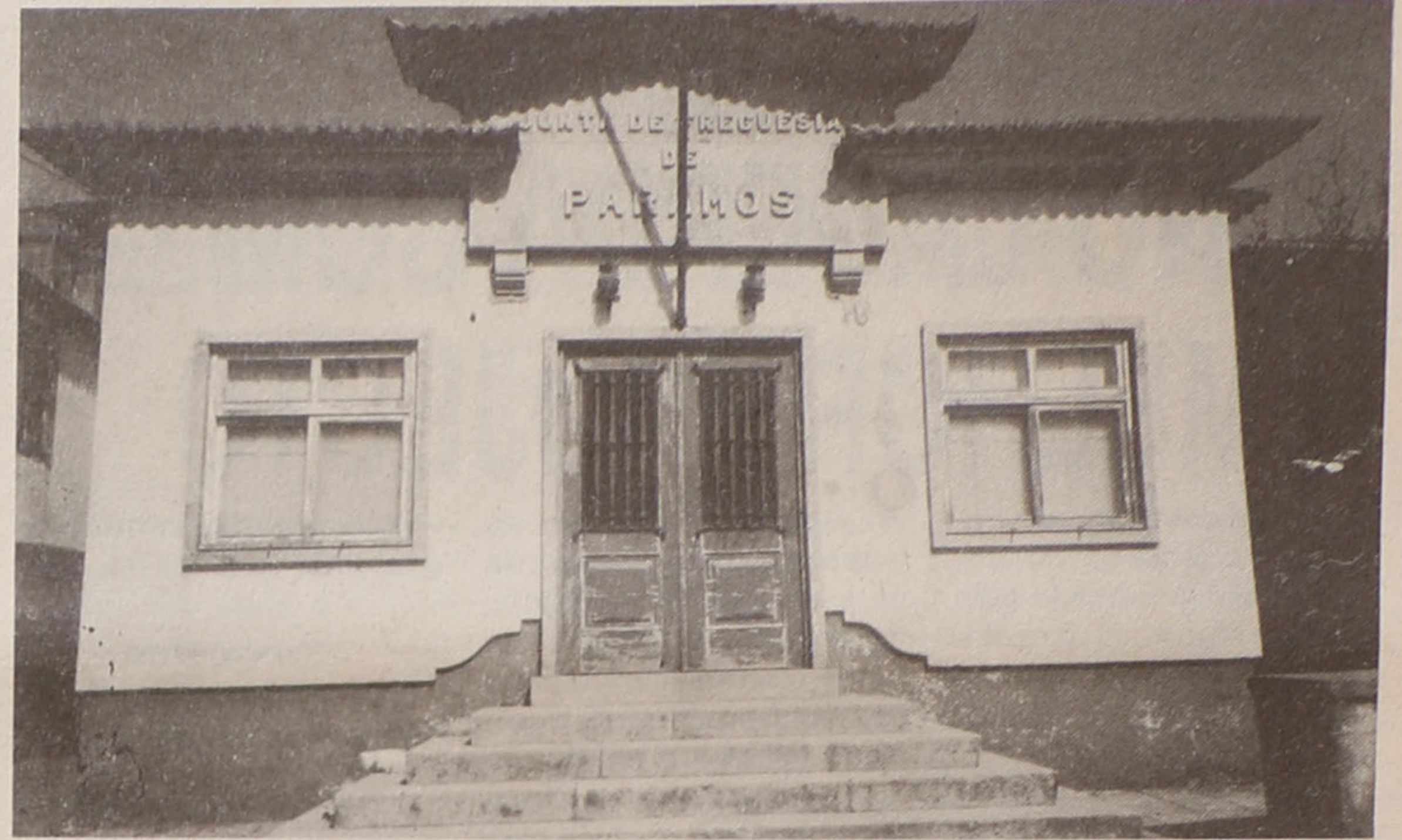
O velho edifício da Junta sempre vai passar a biblioteca
