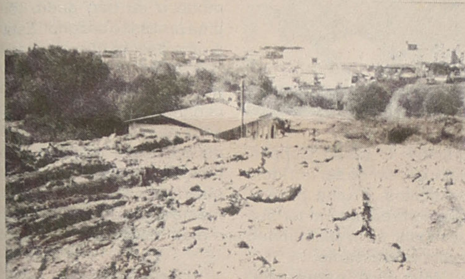
Aterro da Rua nova voltou à Assembleia
