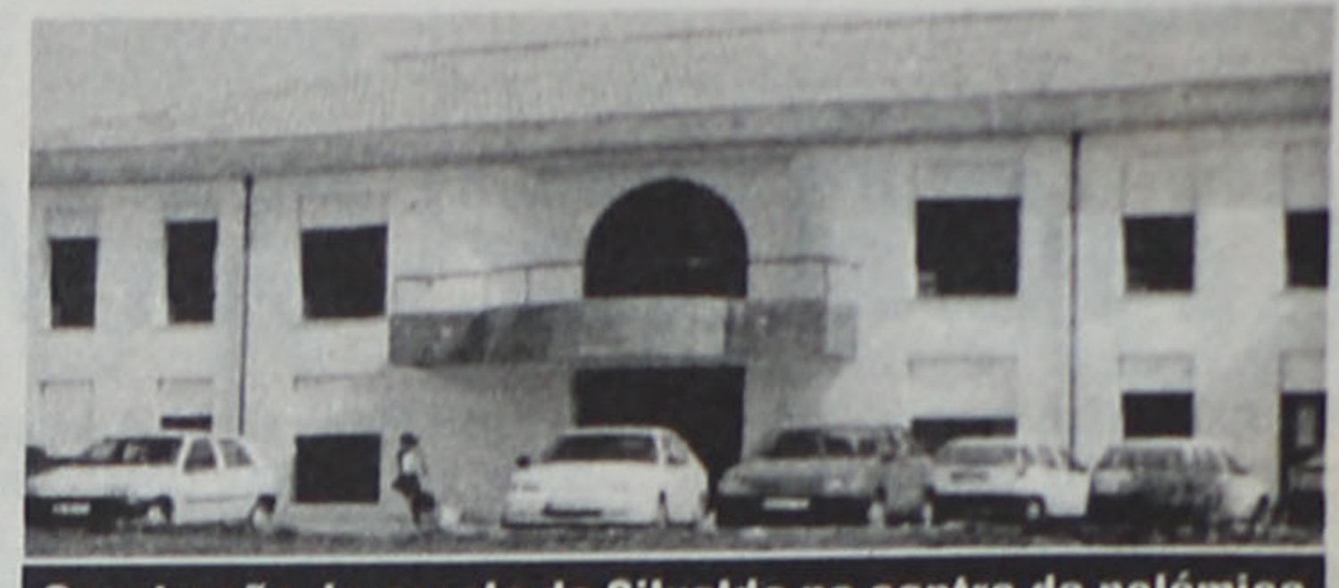
Construção da escola de Silvalde no centro da polémica
